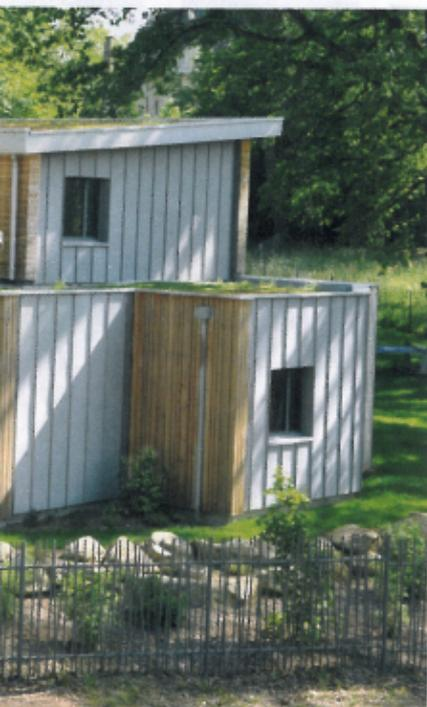
Au nord, la façade paraît encadrée de volumes de plain-pied qui abritent des pièces techniques (garage à vélos, atelier...), ainsi qu'une chambre d'amis. Plates ou monopente, les toitures sont végétalisées (ép. 22 cm), ce qui contribue à l'inertie thermique et au confort acoustique de la maison. Le portail coulissant motorisé est prolongé d'une clôture barreaudée de manière irrégulière («Oobambo™» de Normaclo).
