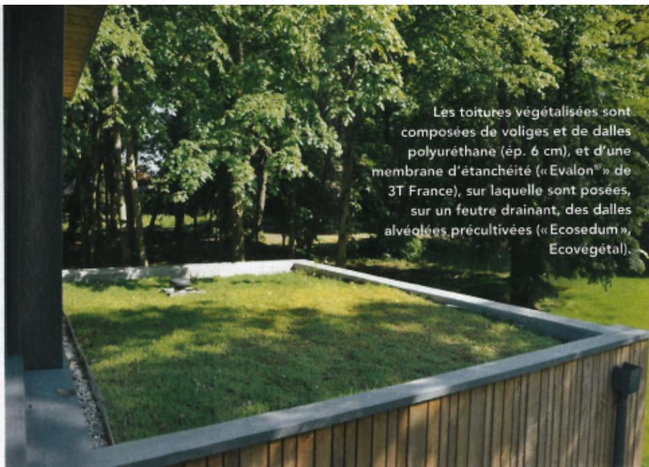
Les toitures végétalisées sont composées de voliges et de dalles polyuréthane (ép. 6 cm), et d'une membrane d'étanchéité (« Evalon<sup>®</sup> » de 3T France), sur laquelle sont posées, sur un feutre drainant, des dalles alvéolées préculтивées (« Ecosedum », Ecovégétal).
