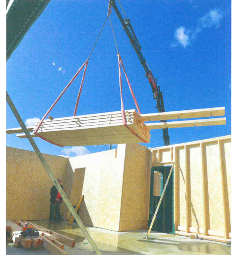
Assemblage « éclair » des panneaux montés à l'atelier.
