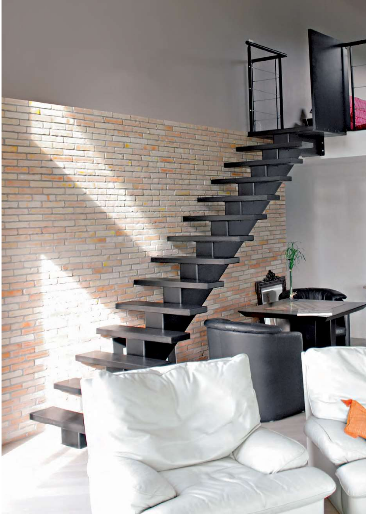
Le mur en briques pleines permet d'apporter un peu d'inertie thermique
