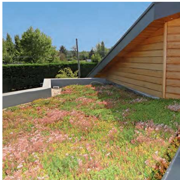
La toiture comporte un toit terrasse végétalisé
