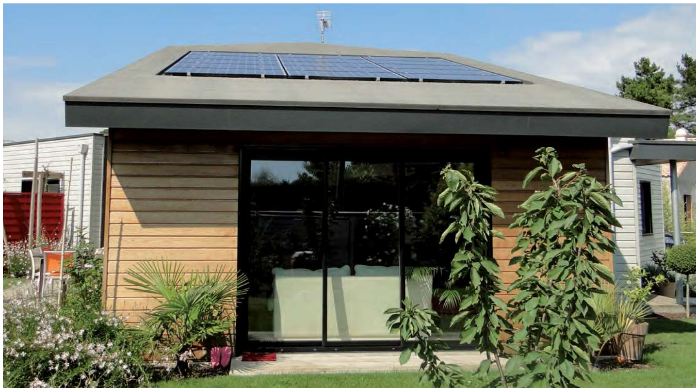
Des panneaux photovoltaïques et thermiques captent l'énergie solaire
