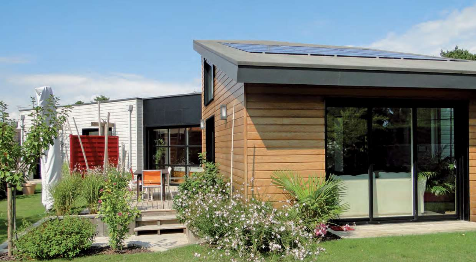
Les différents bardages mettent en valeur les volumes de la maison.
