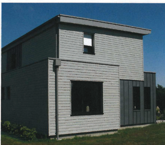
Les pièces de vie sont au nord derrière une façade peu ouverte.
