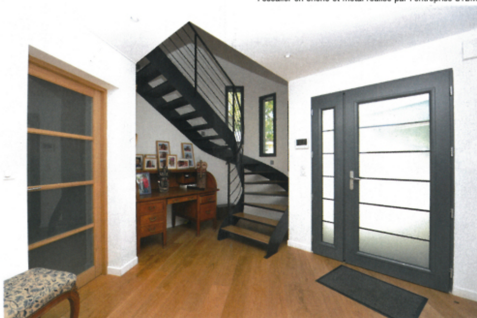
Escalier sur-mesure. Selon les croquis réalisés par les propriétaires, la maison s'articule autour de la cage d'escalier. Le cylindre en zinc qui se démarque à l'extérieur comprend l'escalier en chêne et métal réalisé par l'entreprise STBM.
