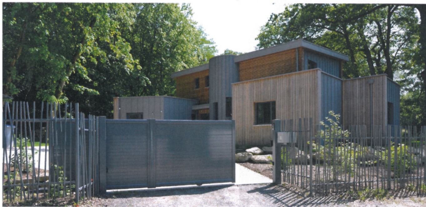
Harmonie du paysage. Le paysagiste Maine Paysage a su créer une parfaite cohérence entre le portail, la clôture et la façade de la propriété : couleur grise, bardage bois et lignes verticales.
