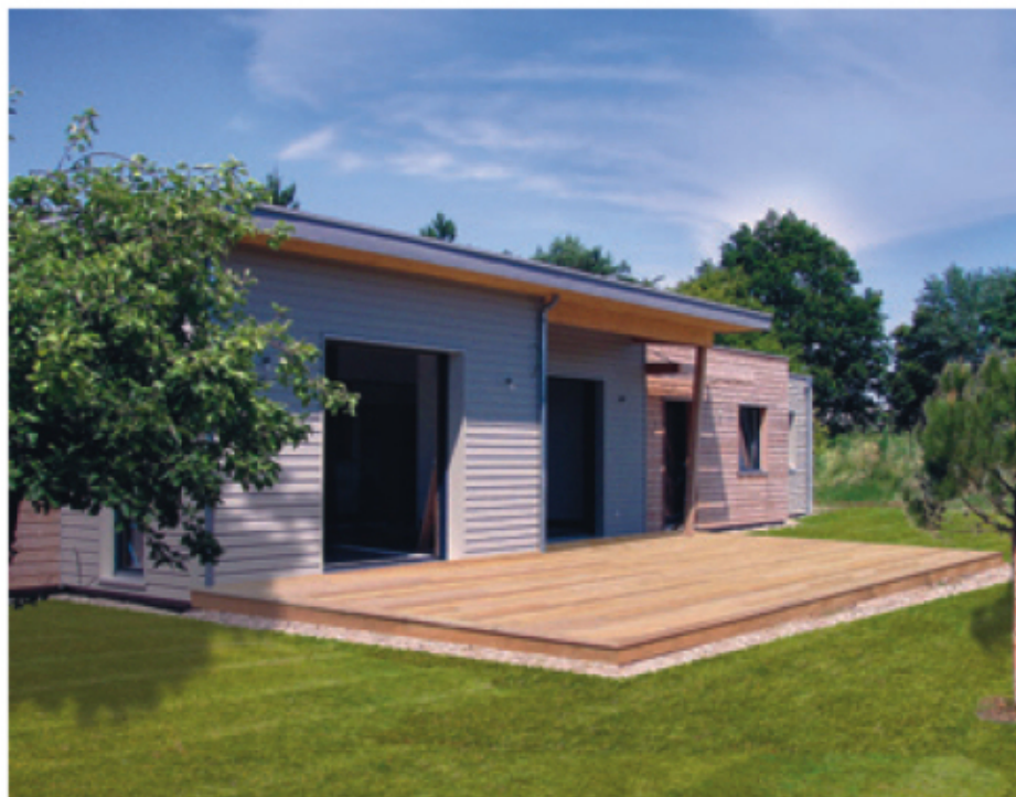
De grandes baies vitrées bois alu favorisent les apports solaires directs en hiver. En été, les baies sont protégées par les dénivelés de toit.
