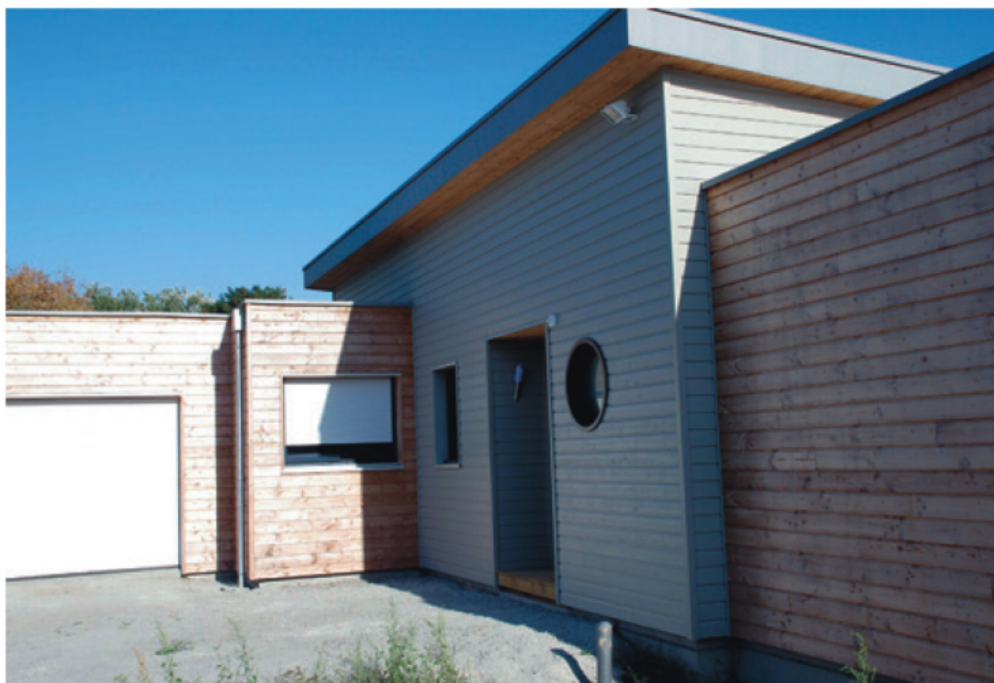
Des modules avec toit plat ou faiblement inclinés pour cette maison qui, à cause des contraintes urbanistiques, ne pouvait s'élever sur deux niveaux.
